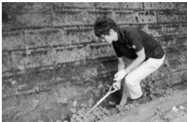
側溝にたまった土砂を取り除く作業
